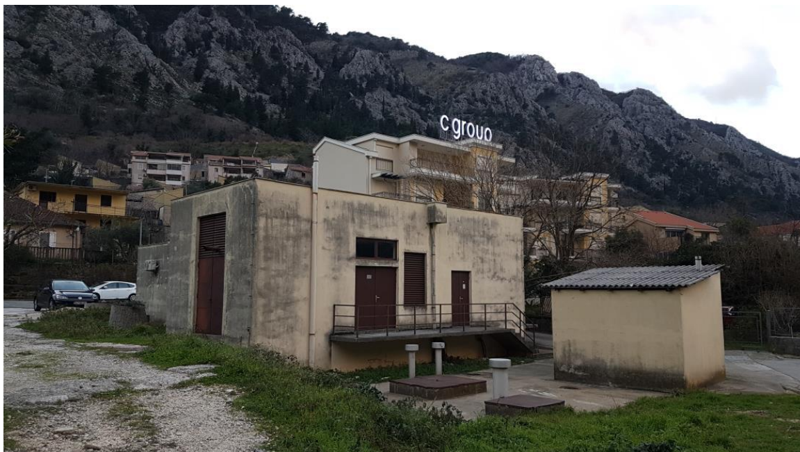
Slika 2. Izgled postojećeg objekta pumpne stanice Peluzica
